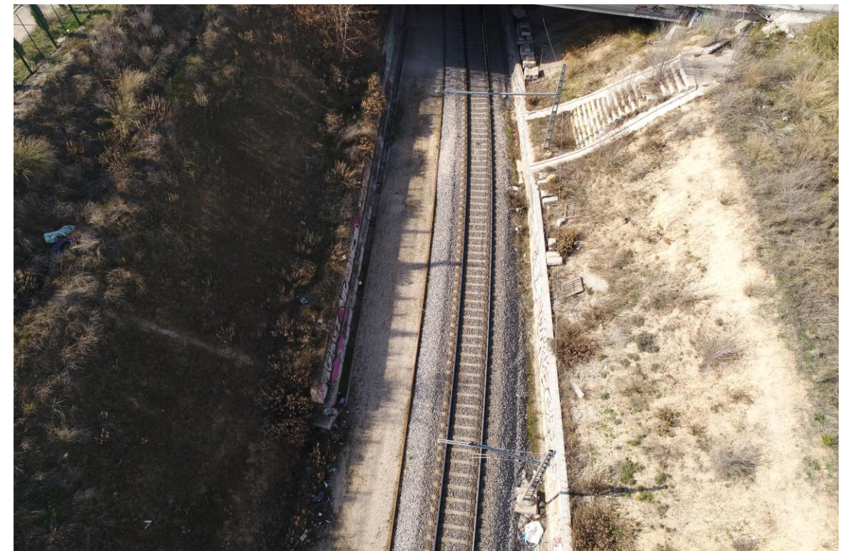
Salida del túnel Chamartín-Barajas
