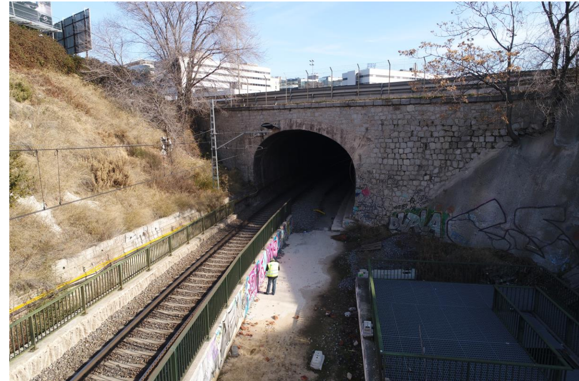
Entrada del túnel Chamartín-Barajas
