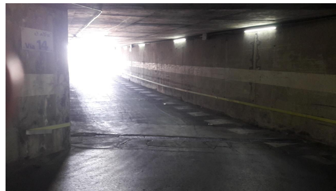
Catering Atocha: Vista de las rampas de acceso a andenes
