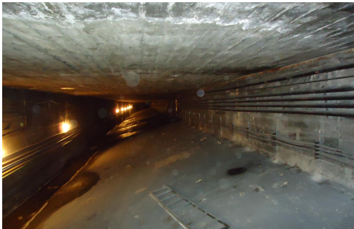
Galería actual bajo vestíbulo de Cercanías bajo vías
