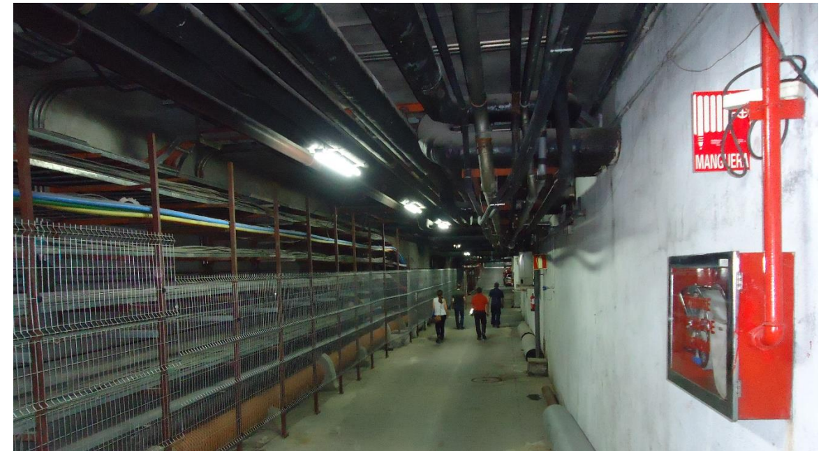
Galería actual bajo andén 1
