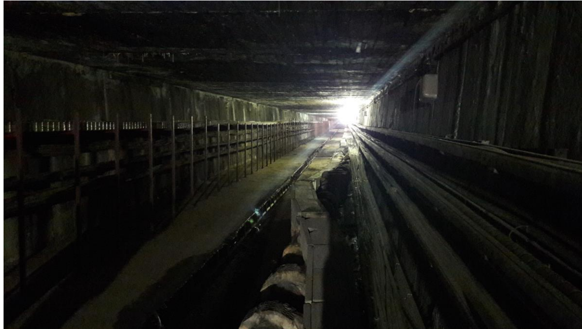
Galería actual lado este
