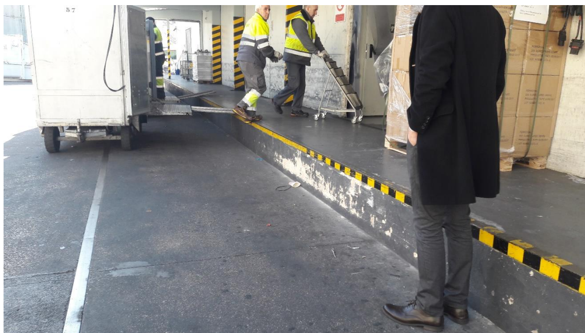
Catering Atocha: Vista del muelle de carga y descarga de carretillas
