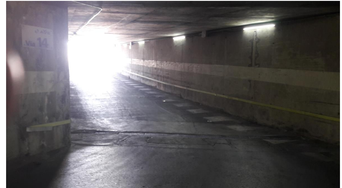
Vista de las rampas de acceso a andenes
