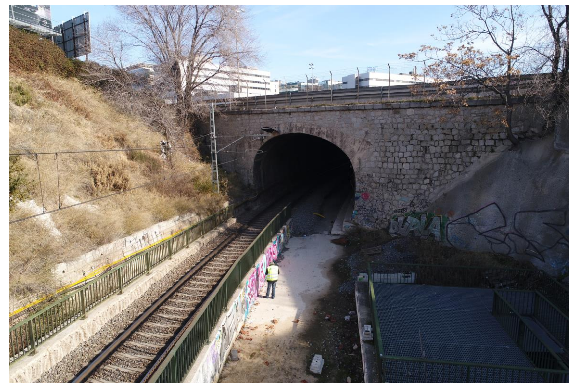
Salida de emergencia existente junto a emboquille Oeste.
