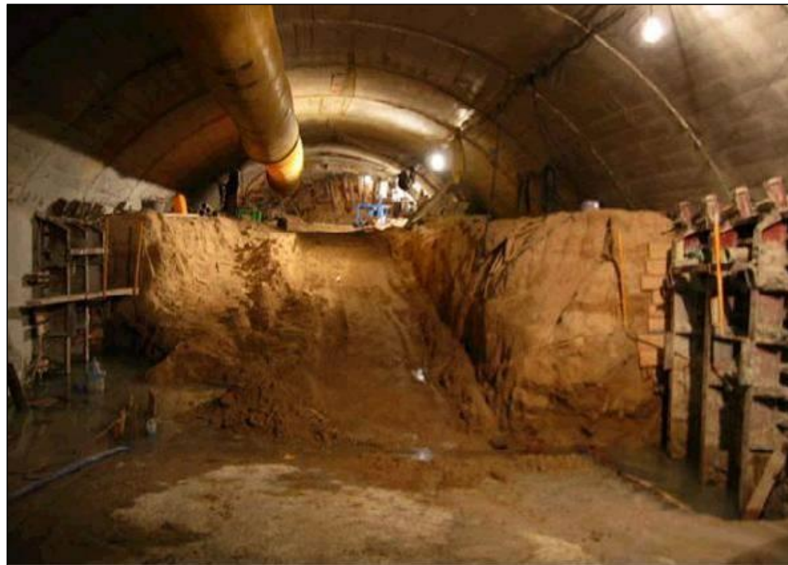
Destroza y ejecución de hastiales desfasados
