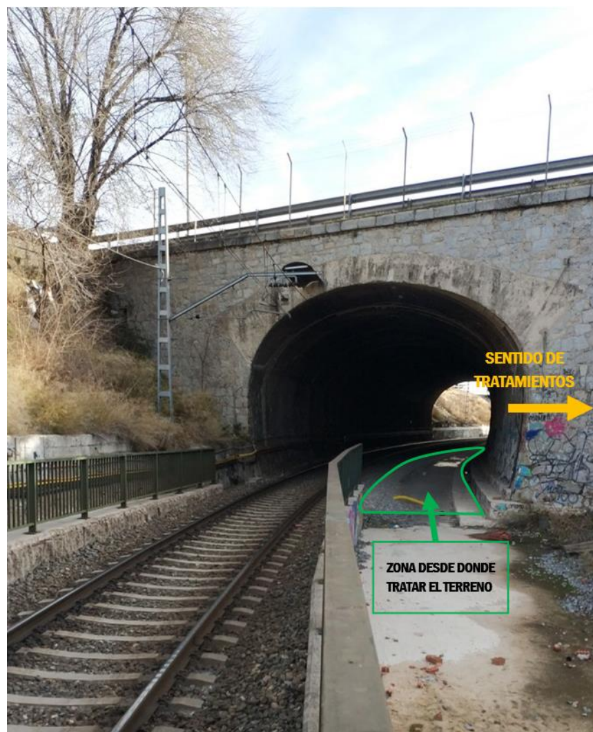
Vista de la zona alternativa de ejecución de tratamientos desde el hastial del túnel existente
