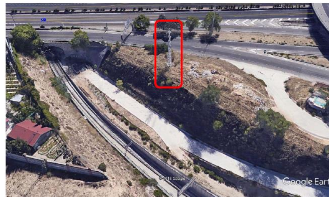
Torre eléctrica existente junto a emboquille Oeste.
