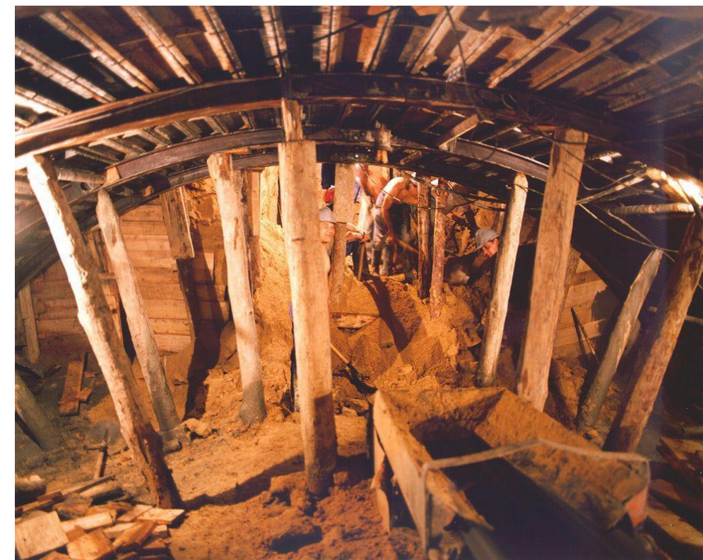
Sostenimiento provisional en bóveda y apuntalamiento de longarinas según el Método Belga
