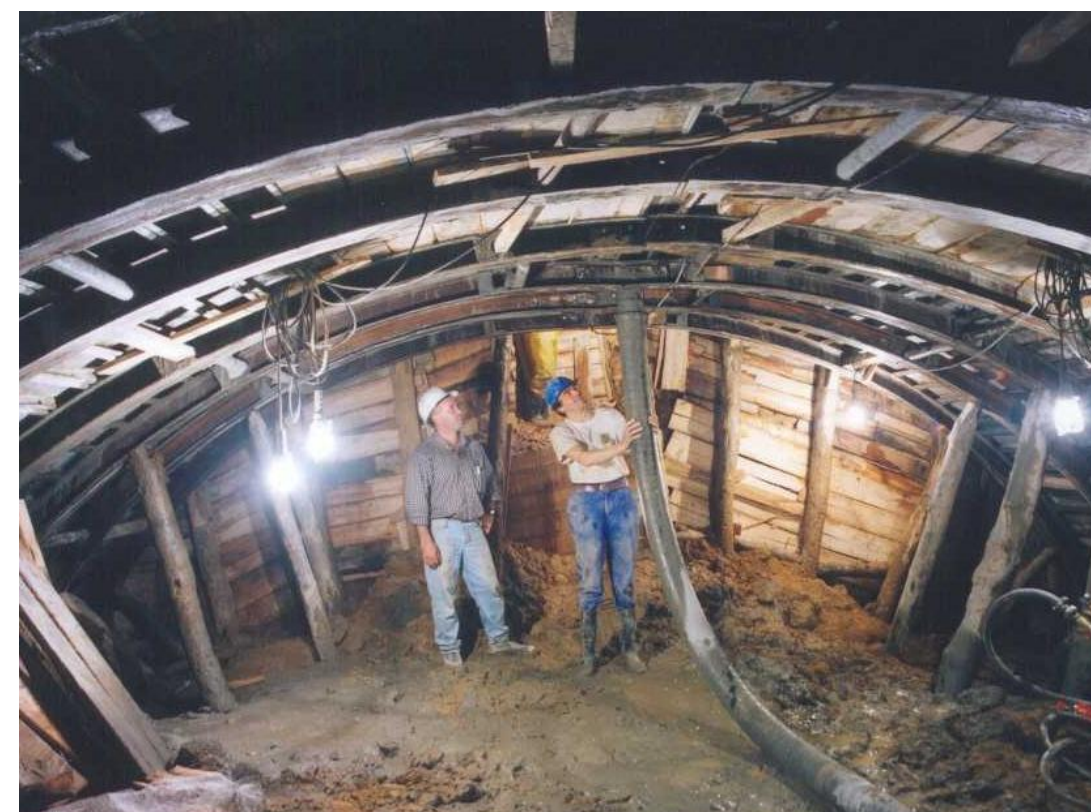
Encofrado y hormigonado de la bóveda
