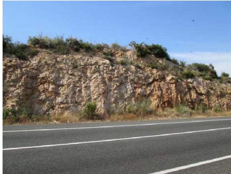
Fotografía 1. Afloramiento de dolomías jurásicas en N-340.
