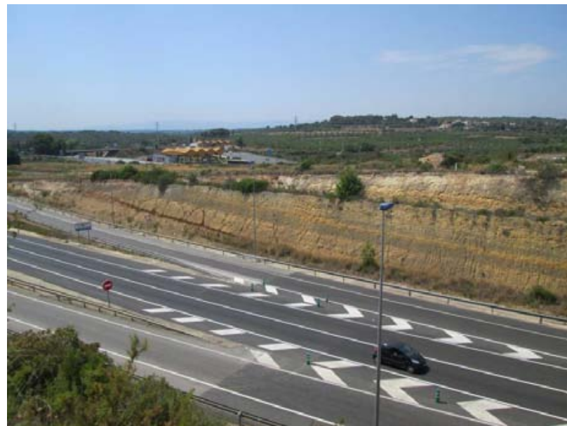
Fotografía 5. Talud en Unidad geológica Tcam.
