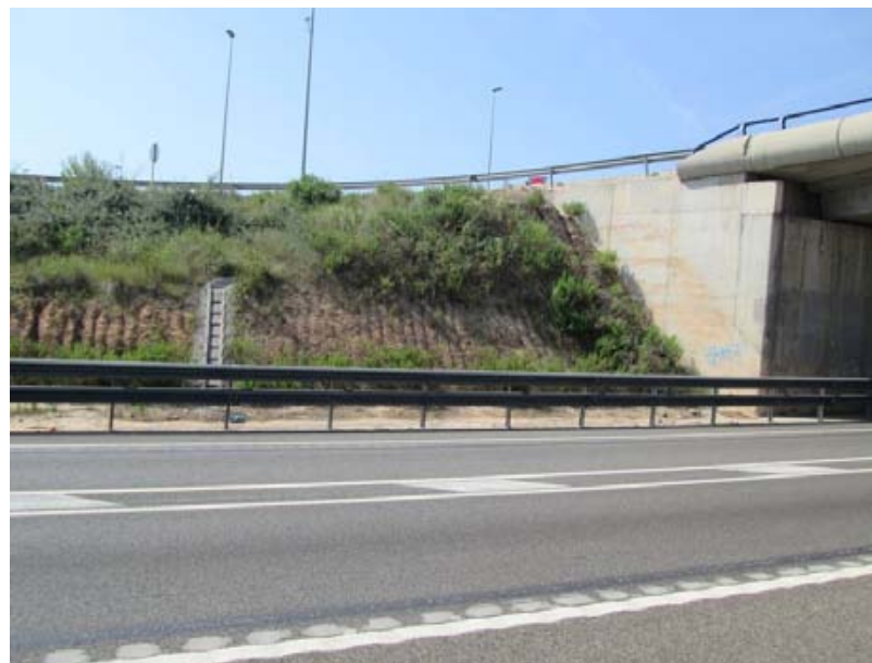
Fotografía 7. Rellenos compactados en estribo de Paso Superior
