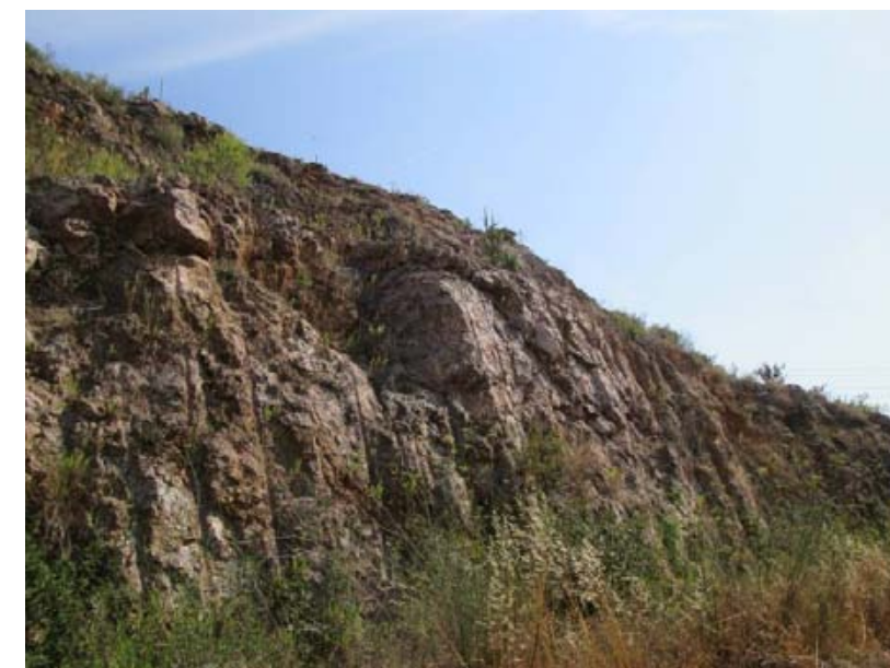
Fotografía 19. Cuña provocada en borde de berma en dolomía jurásica
