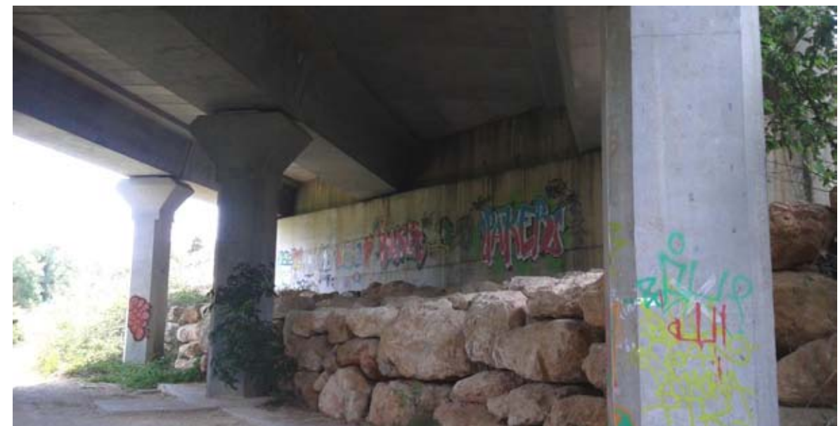
Estructura existente N-340 / Gaià
