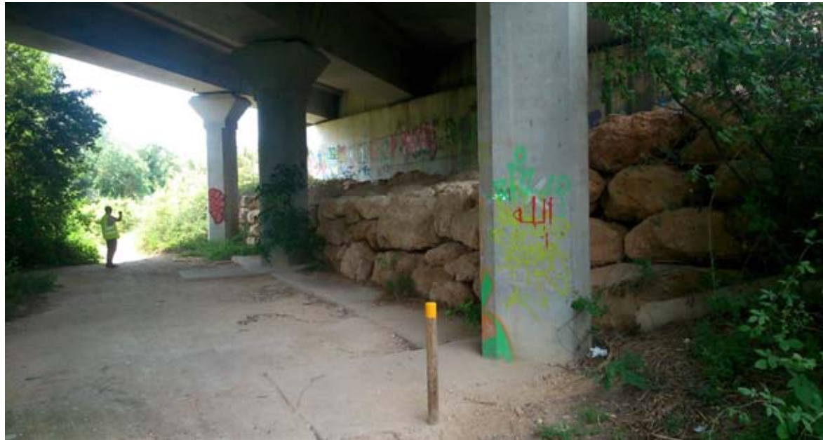
Estructura existente N-340 / Gaià
