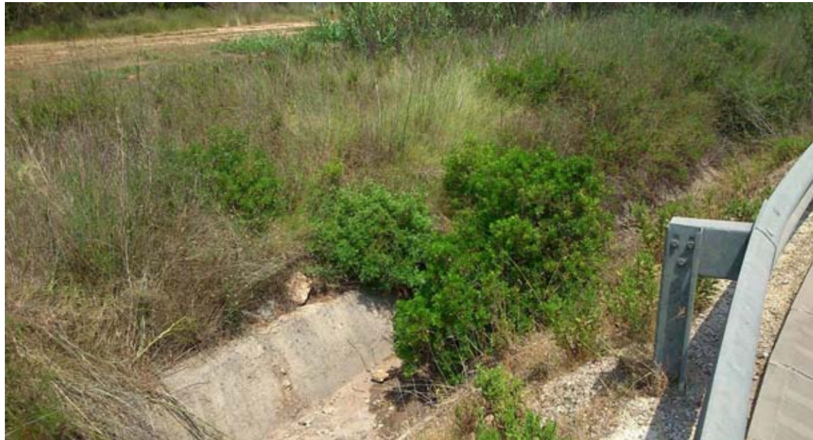
Cunetones existentes que conducen la escorrentía hacia la entrada de la OD 12+4
