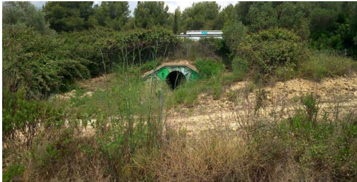
Desembocadura de la obra de drenaje OD 8.1. AP-7
