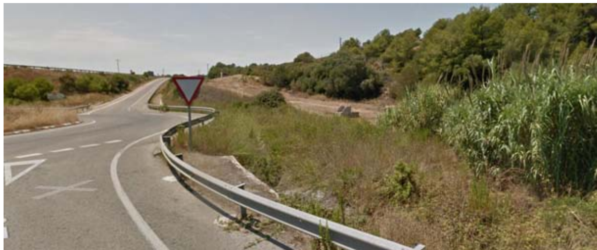
Entrada del tramo 1 de la OD 12+4
