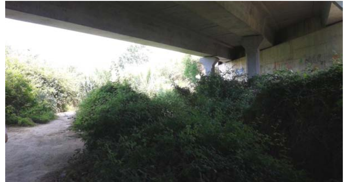
Estructura existente N-340 / Gaià
