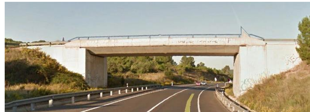
Estructura E-7. Paso superior existente a reponer.
