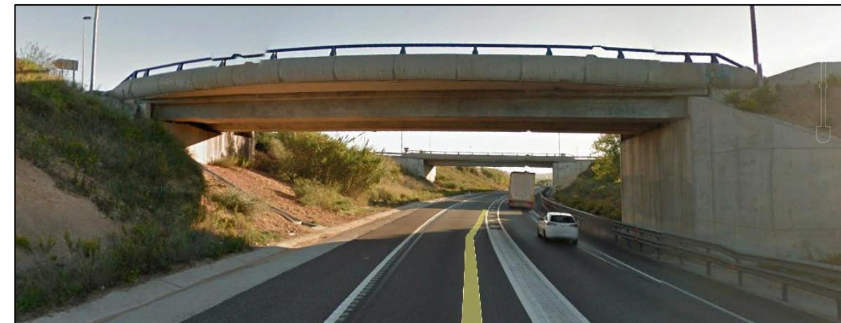
Paso superior oeste (P.K. 100+600). Vista frontal. Fuente: Google Earth
