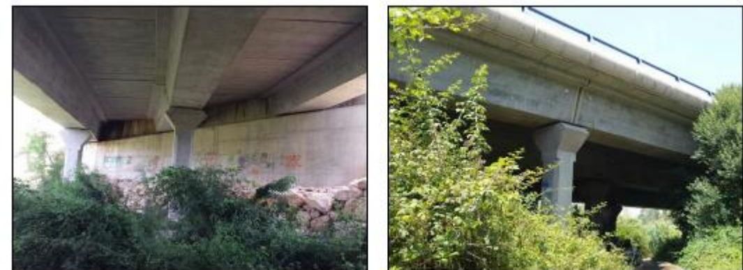
Vista calzada dirección Tarragona
