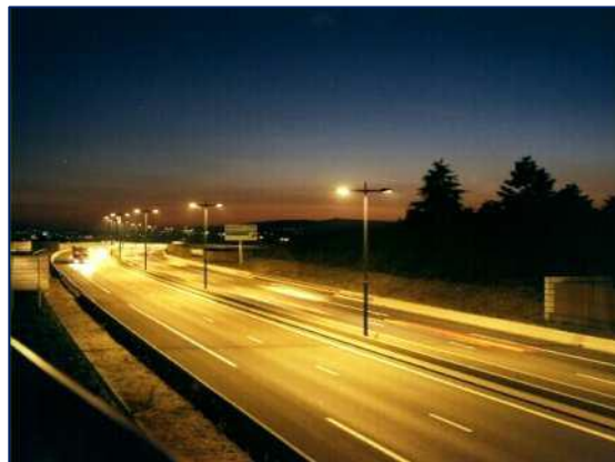
Figura 13: Tramo de cielo abierto iluminado con VSAP
