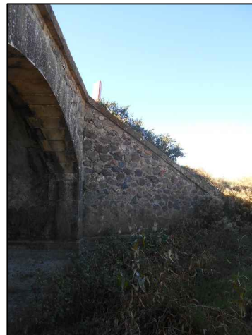
VISTA ALETA AGUAS ABAJO
