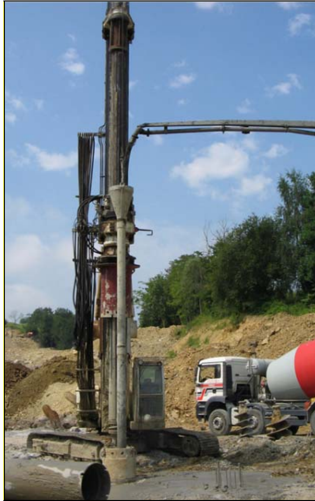
Hormigonado de pilotes con tubo tremie.
