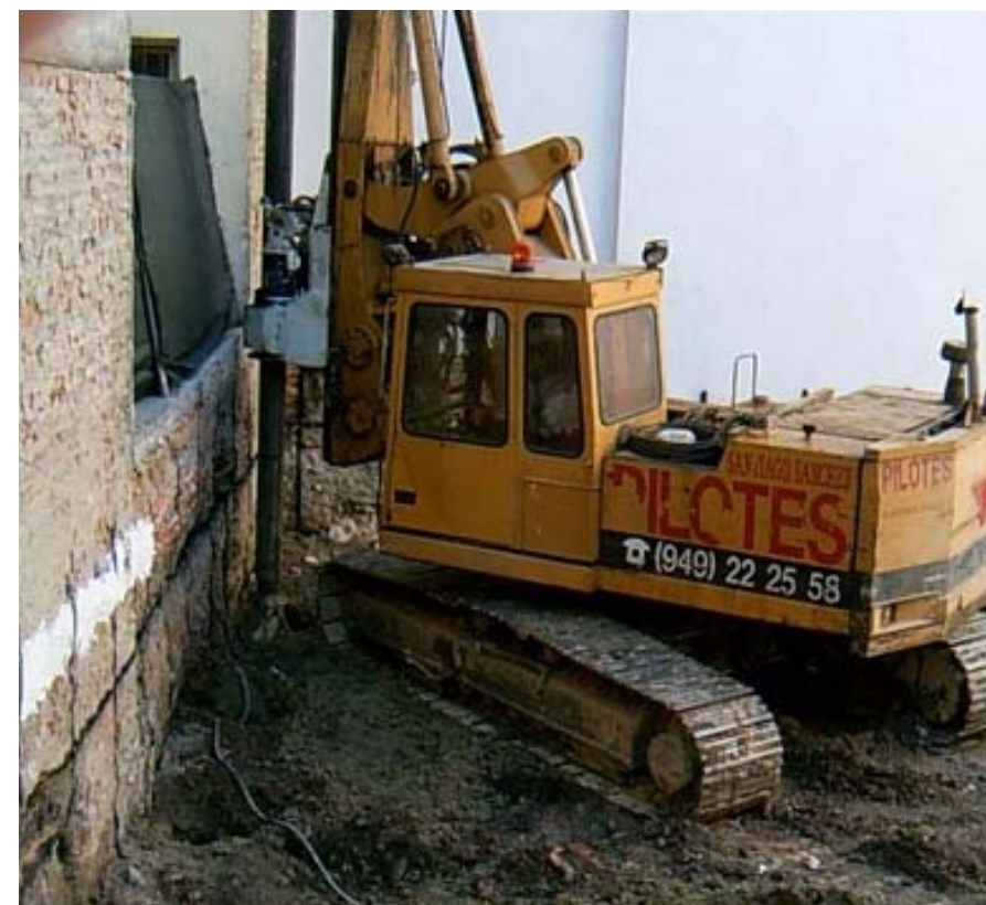
Ejemplo de operatividad de equipos de ejecución de pilotes.
