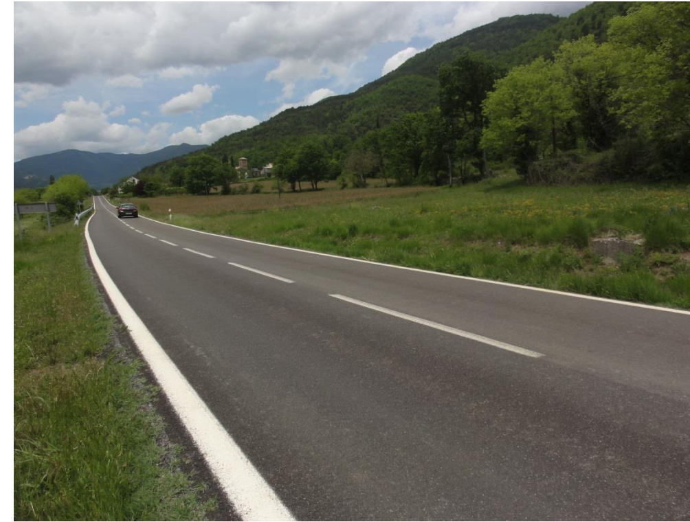
Sifón de riego en desuso cruzando la carretera
