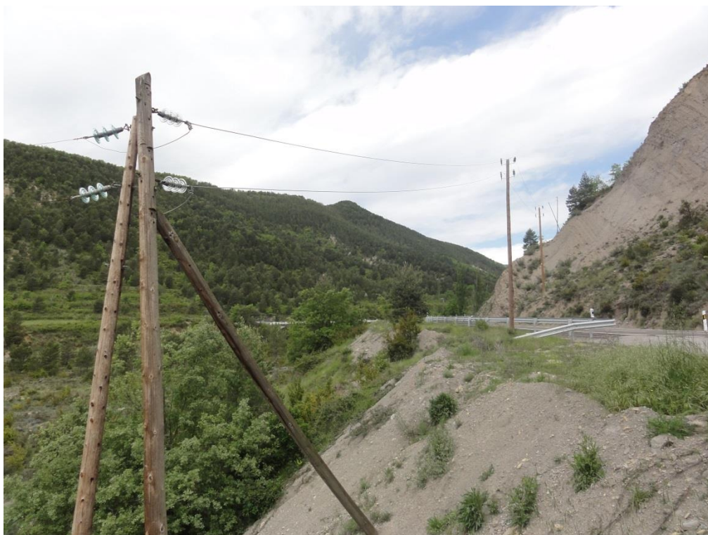
Línea eléctrica de media tensión con postes de madera
