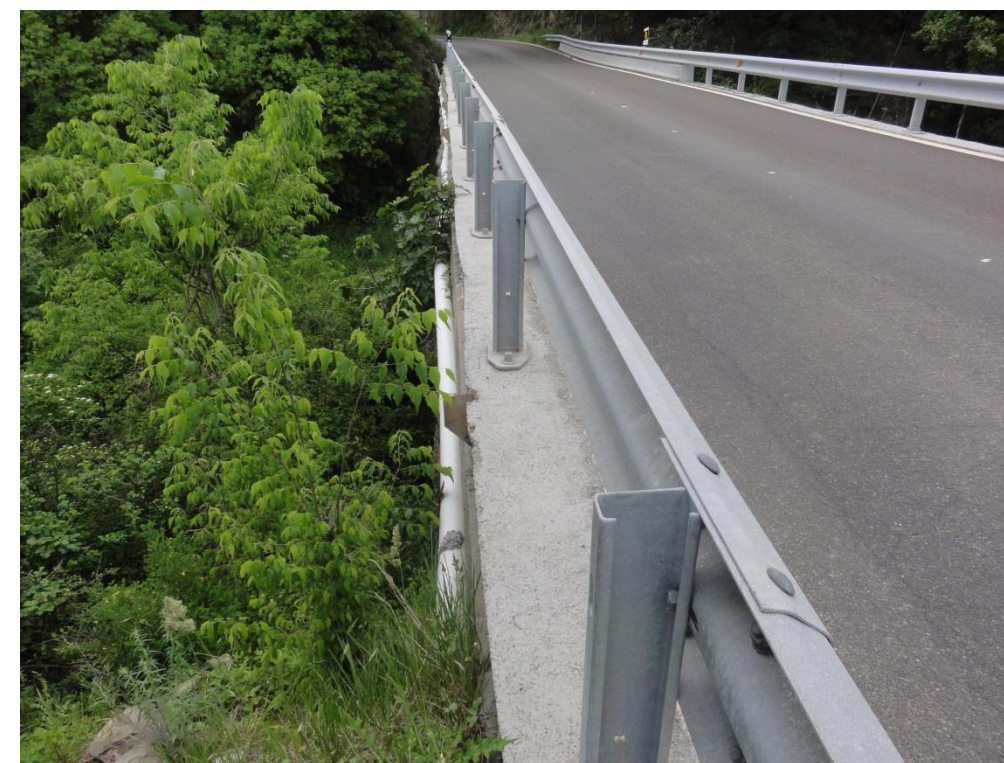
Tubería de abastecimiento anclada a estructura próxima en Fiscal
