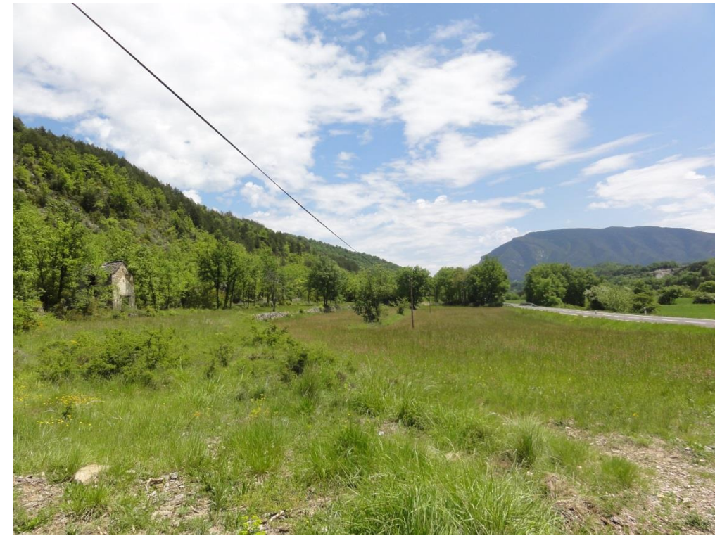
Línea de teléfonos aérea paralela a la carretera
