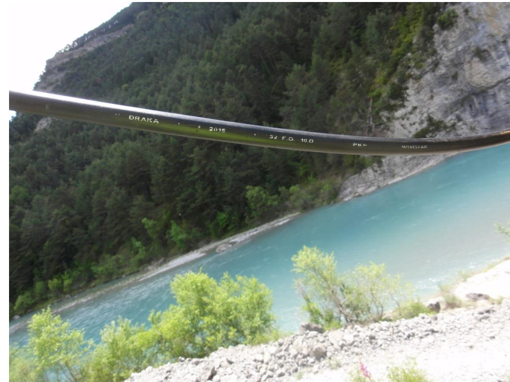
Línea telefónica de F.O. en construcción en el túnel de Balupor
