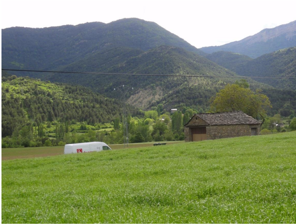
Línea eléctrica aérea de media tensión con apoyos metálicos
