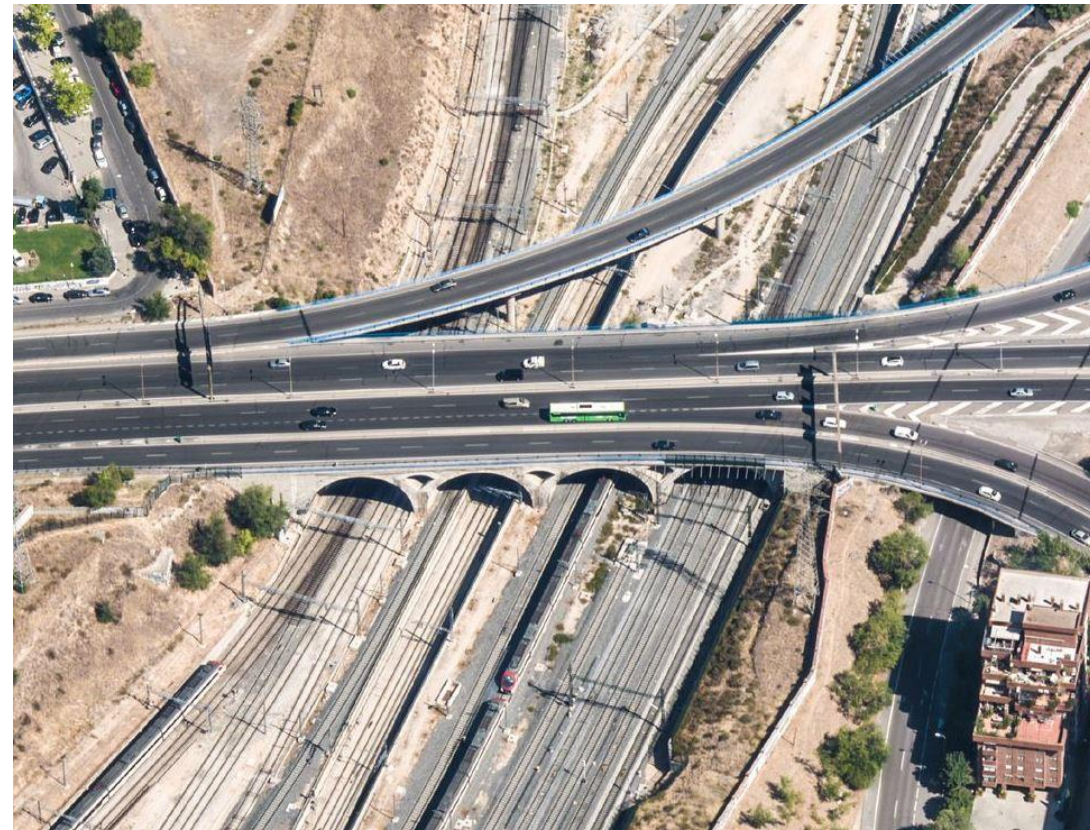
Vista hacia el Norte del Cruce de la playa de vías con el Nudo M-30 y M-11
