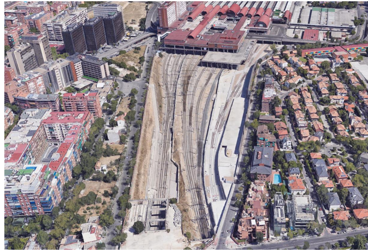
Vista de la cabecera sur de la estación y conexión con los túneles de Sol, Recoletos y nuevo túnel UIC Atocha - Chamartín
