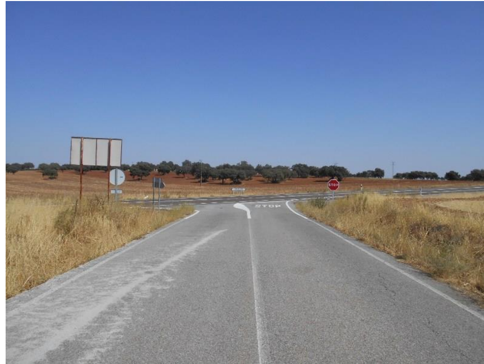
Vista desde carretera de Casas de Reina
