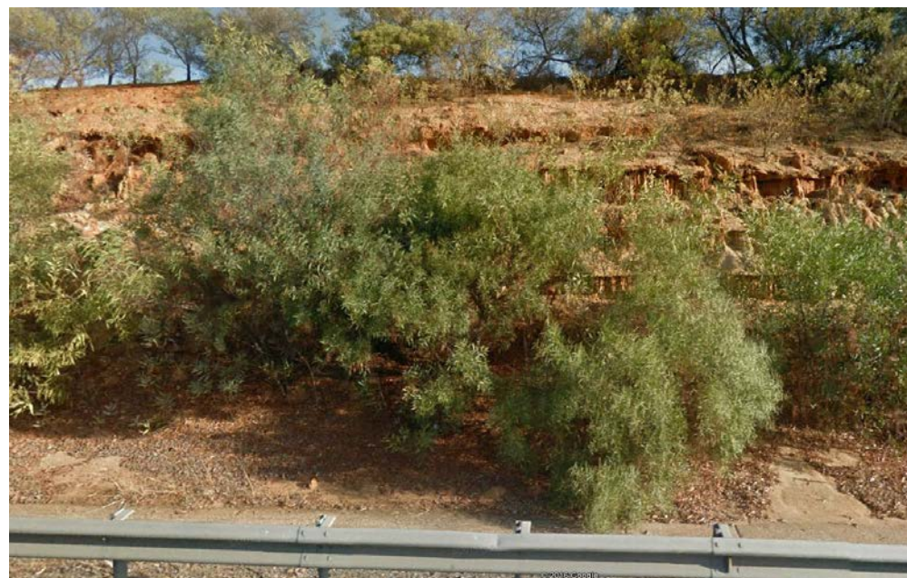
Figura 1.- Desmonte en la A-49, en la zona final del proyecto
