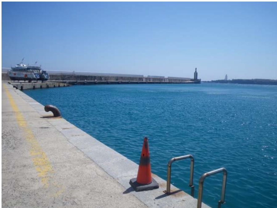
Figura 11. Zona de maniobra. Se observa a la E/P L'ATLANTIDA en seco, tras su recuperación
