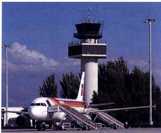
Ilustración 2.9.- Torre de Control
