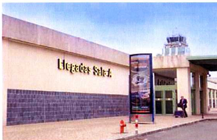
Ilustración 1.2.- Edificio Terminal del Aeropuerto de Santiago
