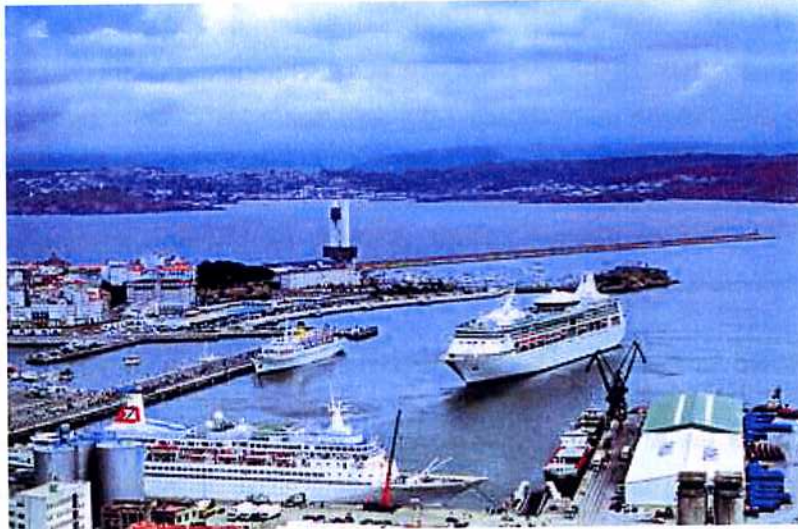
Ilustración III.11.- Situación actual del Puerto de A Coruña
