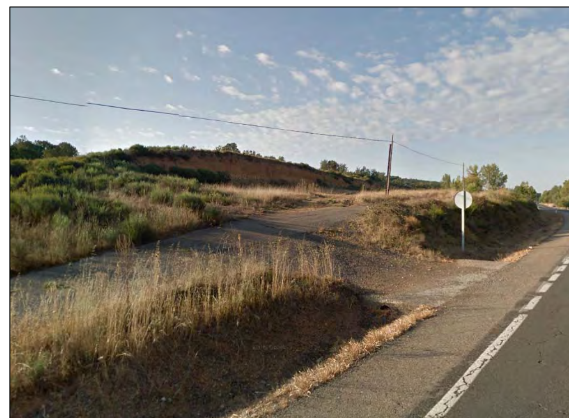
Imagen 03. Línea aérea telefónica en el entorno del acceso al centro de conservación.
