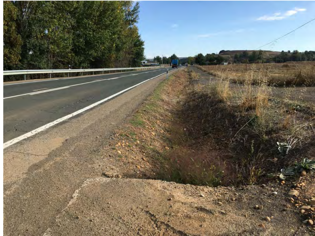
Vista punto de acceso existente entrada a futuro centro COEX. Vista a pk+
