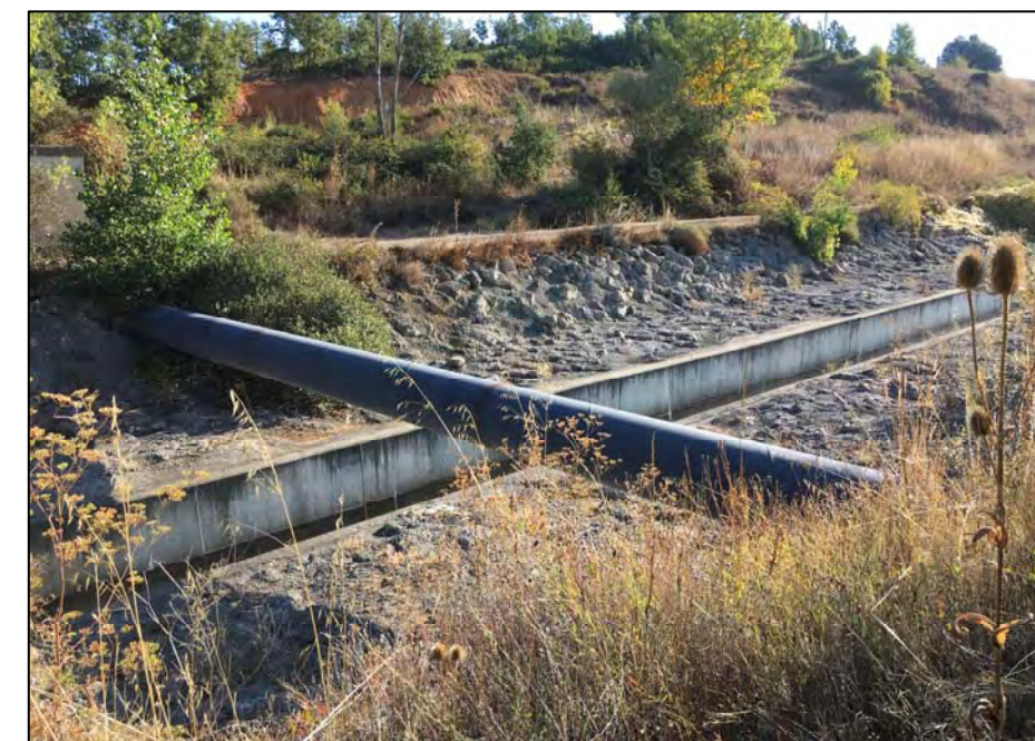
Imagen 05. Vista del cruce de la acequia sobre el canal procedente del Canal de Payuelos.
