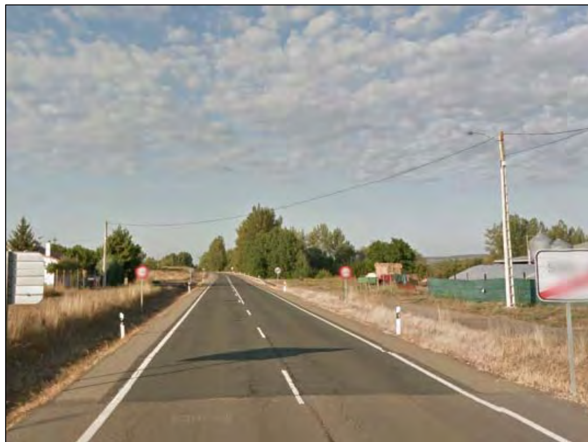
Imagen 02. Cruce de la línea aérea para acometida a vivienda (a la izquierda de la imagen).
