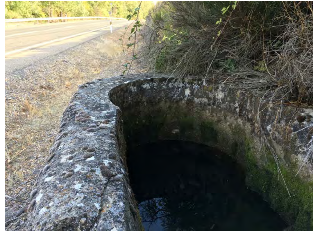
Pozo servicio afectado acequia de riego paso bajo calzada
