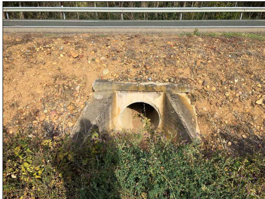
Imagen 01. Vista de la embocadura en el margen derecho de la calzada
