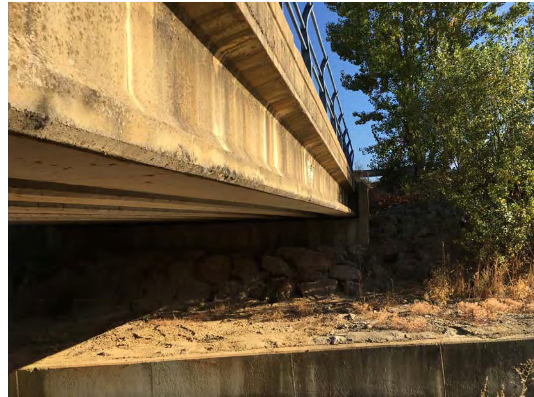
Paso sobre canal vista inferior
