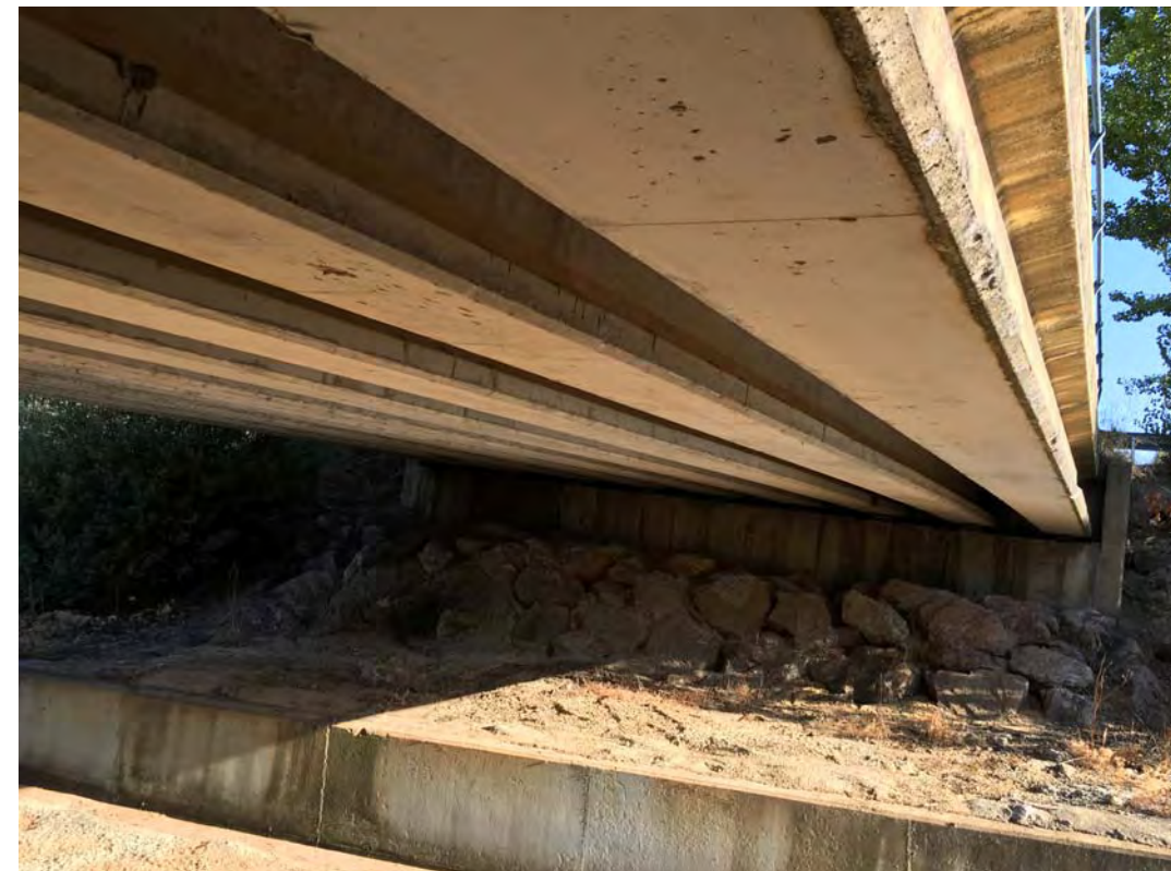
Paso sobre canal vista inferior
