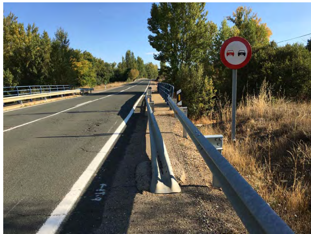
Inicio de la actuación paso sobre canal.
