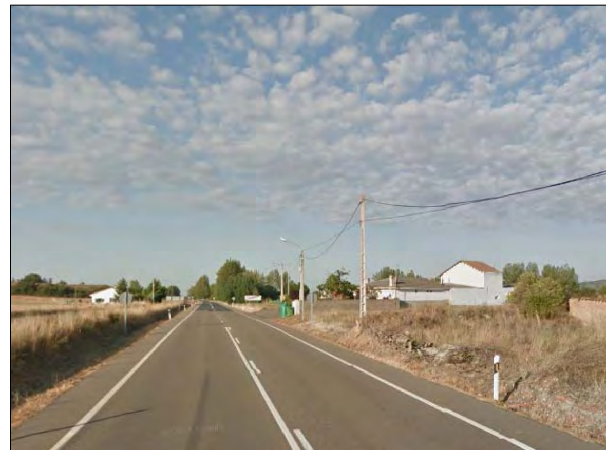
Imagen 01. Vista de la línea eléctrica y de alumbrado paralela a la carretera.
