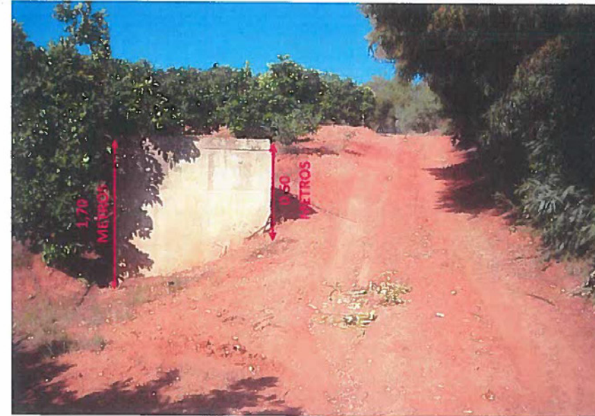
ARQUETA EXISTENTE EN LA CALZADA IZQUIERDA EN EL PK 117+975
